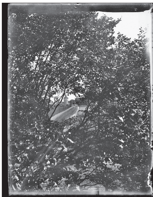
Ryc. 12. Wieża ciśnieni przy ulicy Szczecińskiej. Fot. MAH w Stargardzie
