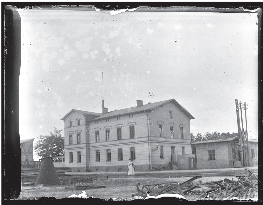
Ryc. 11. Budynek na terenie stargardzkich warsztatów kolejowych. Fot. MAH w Stargardzie
